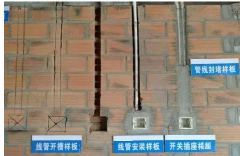
图 4.2.2-4 开槽图尺寸
