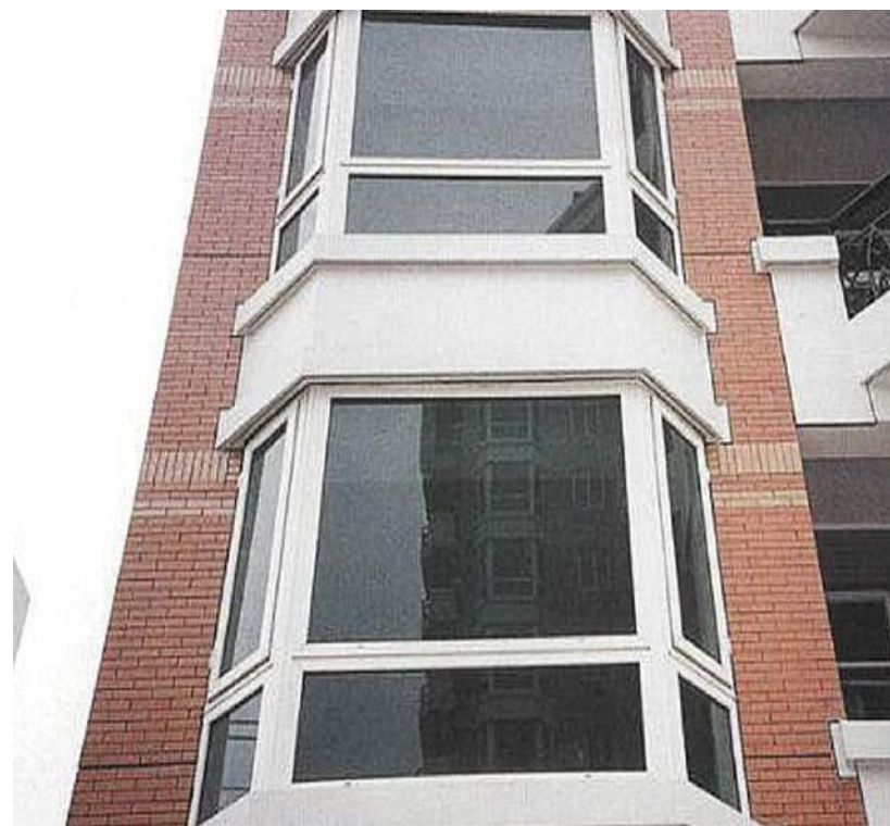
图 6.3.2-2 外墙面砖层分格缝
