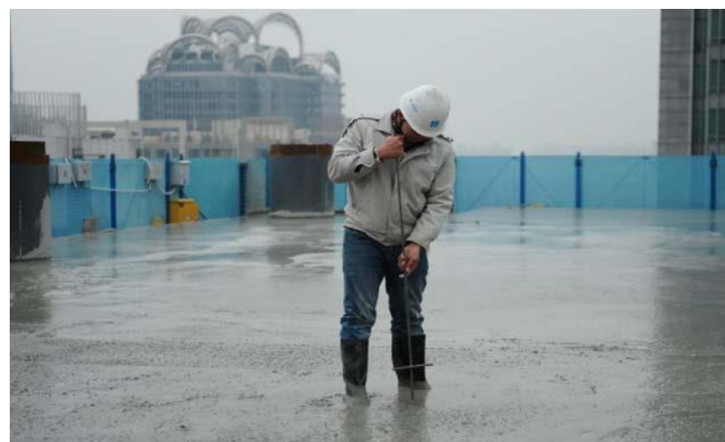
图 2.1.2-4 采用自制钢钎检查板厚
