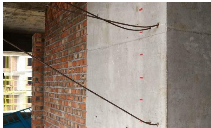
图 4.3.2-4 通过划线控制拉结筋的位置
