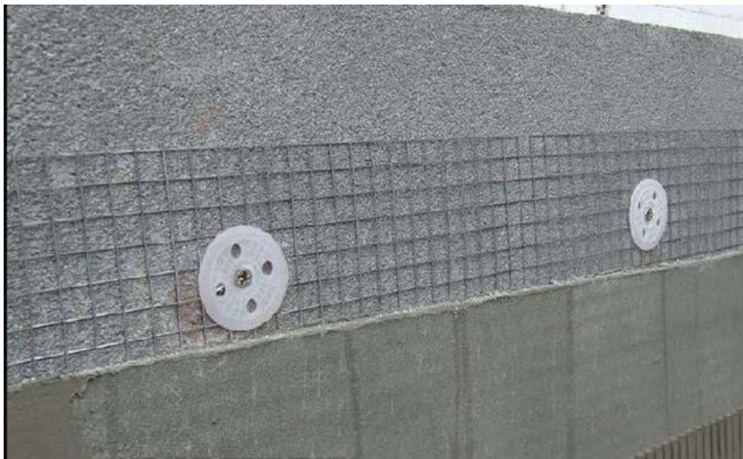
图 6.2.2-1 外墙保温板安装图
