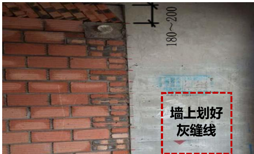
图 4.3.2-3 剪力墙上划出砌筑控制线
