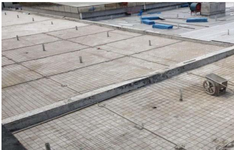
图 5.1.2-1 刚性层钢筋安装及分格缝设置
