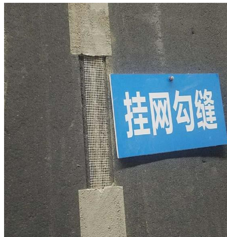
图 3.1.2-2 轻质隔墙板缝挂网勾缝图
