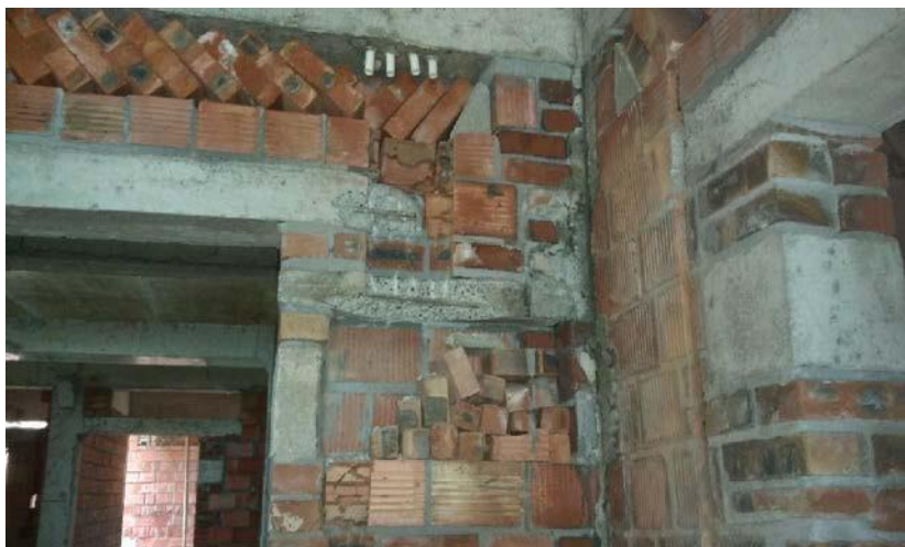
4.2.3 图 4.2.1-1 砌体墙在开槽处开裂 图 4.2.1-2 开槽处抹灰面开裂
