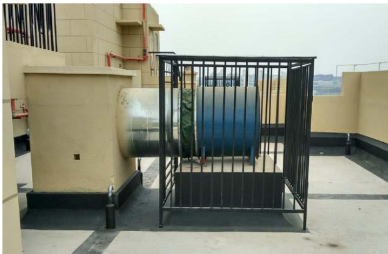
图 5.3.2-1 井道出屋面做法实物图
