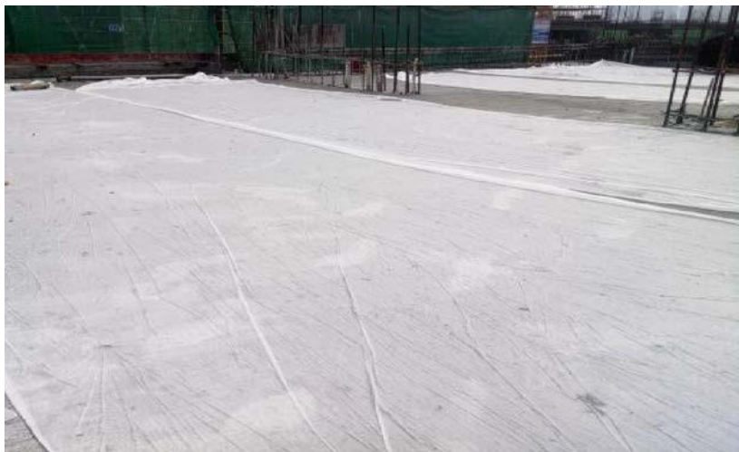
图 2.1.2-9 现浇板面覆膜养护
