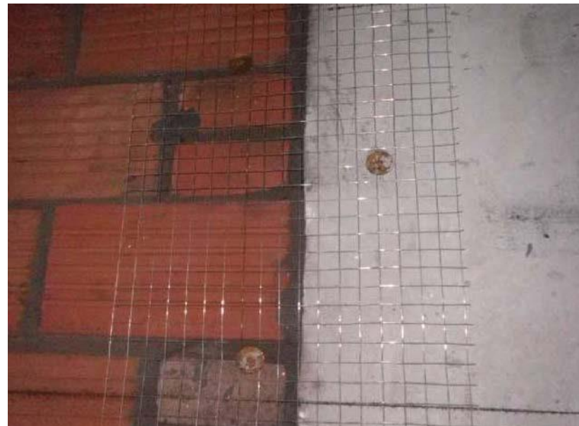
图 4.1.2-2 不同材料交界处挂网图
