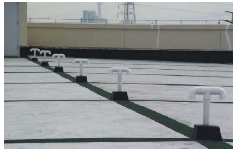
图 5.1.2-2 屋面排气管实物图
