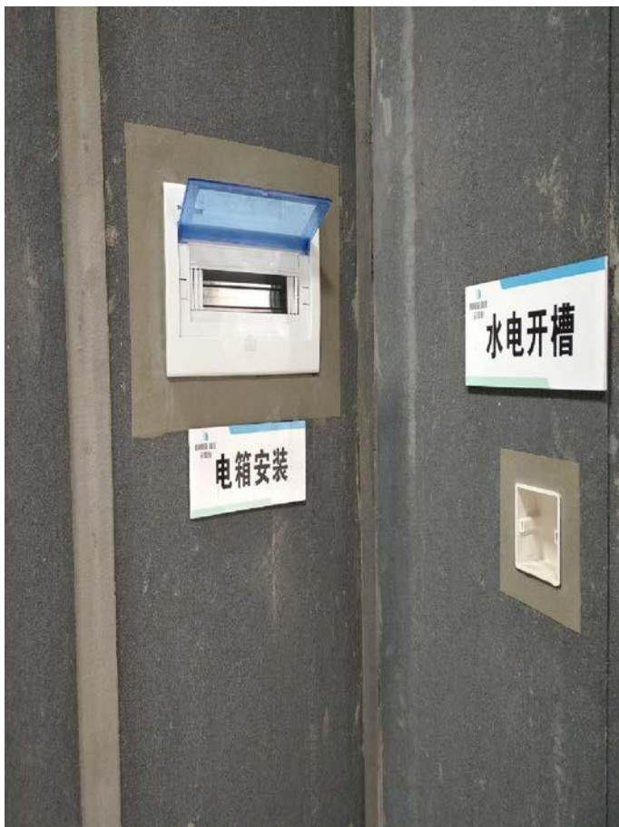
图 3.1.2-7 水电开槽成型质量实物图
