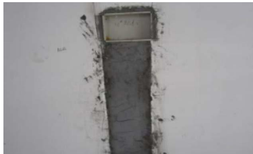
4.2.3 图 4.2.1-1 砌体墙在开槽处开裂 图 4.2.1-2 开槽处抹灰面开裂
