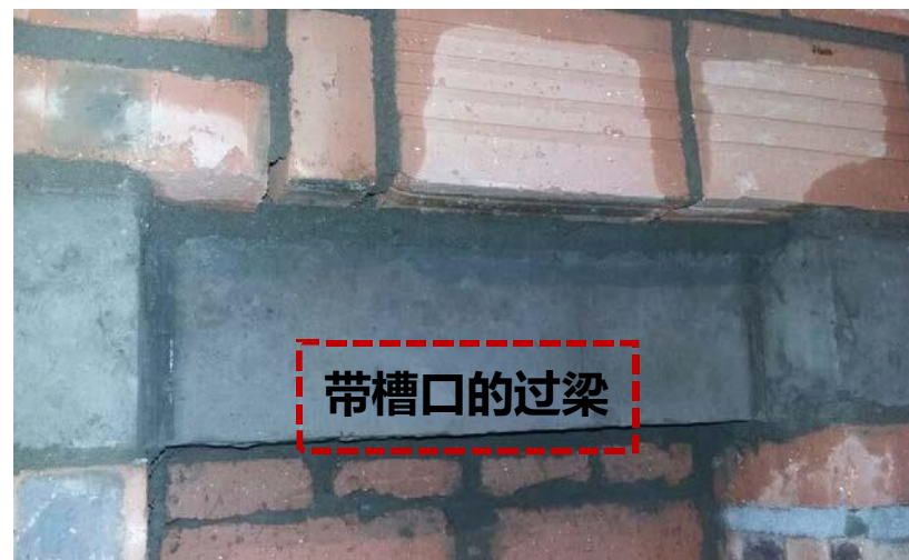
图 4.2.2-6 带槽口的过梁安装图
