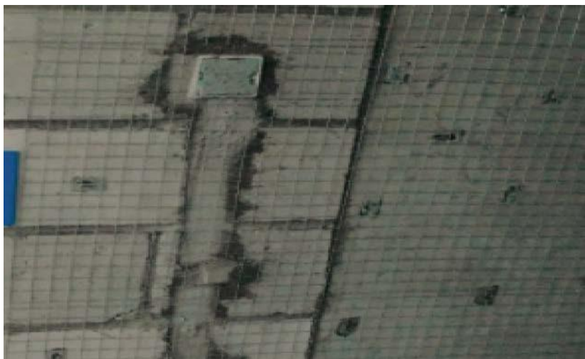
图 4.2.2-7 槽口的挂网图
