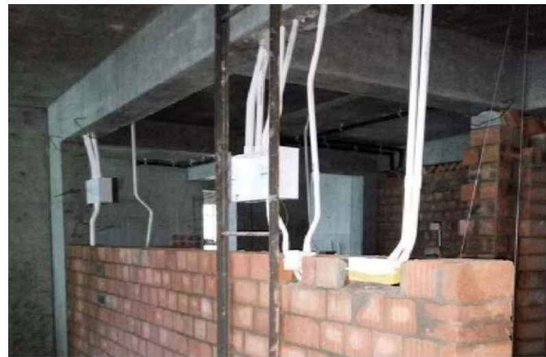
图 4.2.2-2 线管随砌随埋
