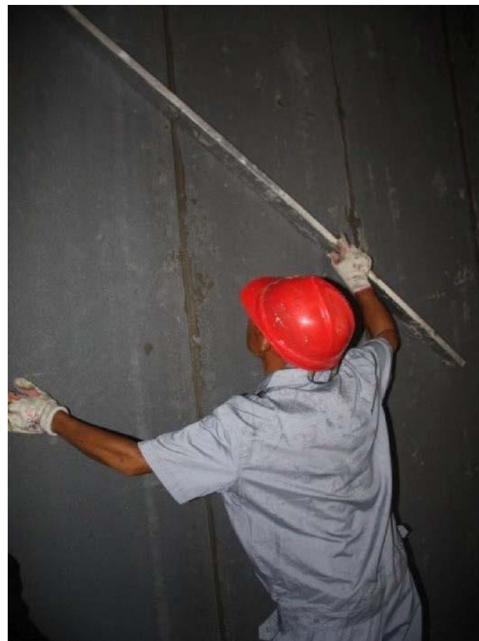
图 3.1.2-6 墙板测量
