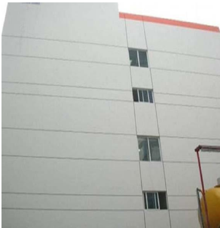
图 6.3.2-1 外墙涂料层分格缝
