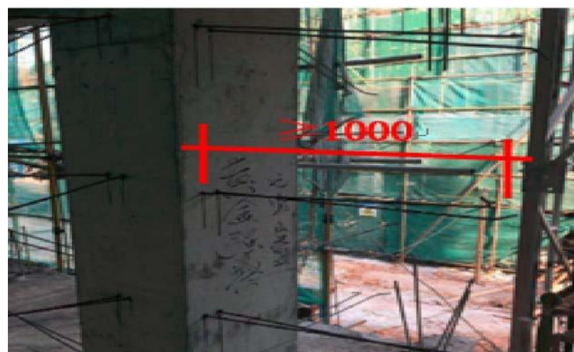
图 4.3.2-2 柱上拉结钢筋
