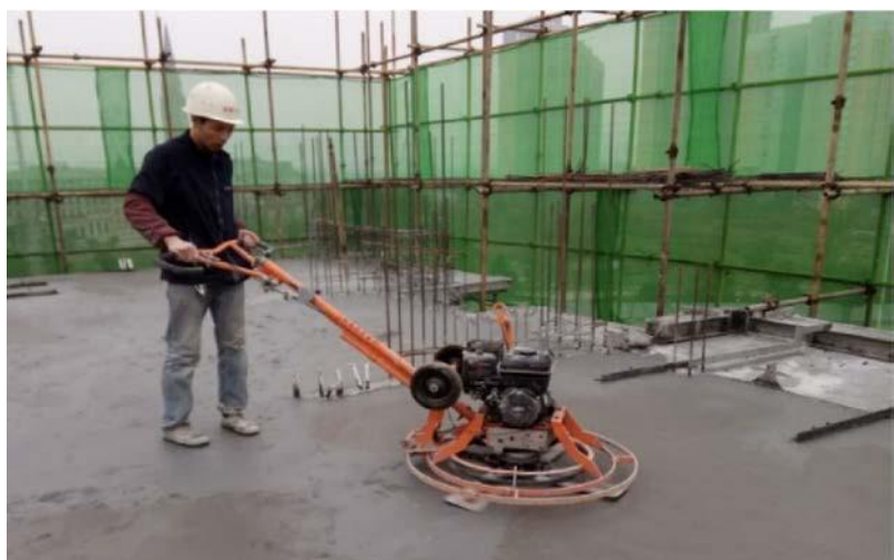
图 2.1.2-7 现浇板机械二次收面
