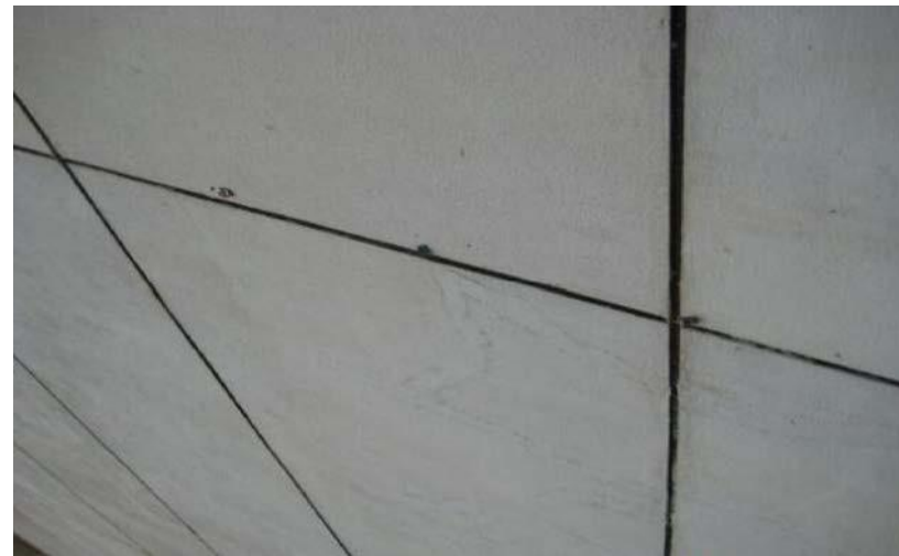
图 6.2.2-2 抹灰层设置分格缝
