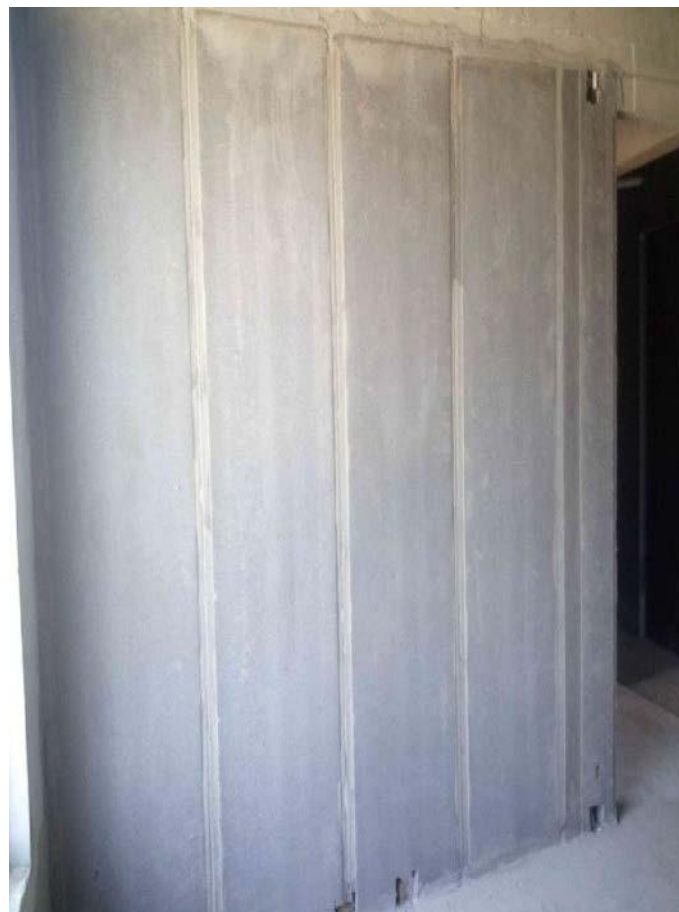
图 3.1.2-8 墙板嵌缝成型质量实物图
