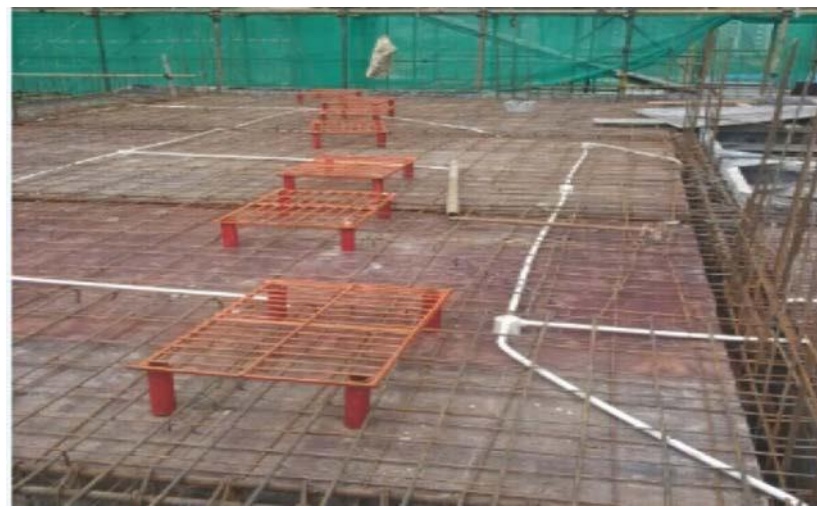
图 2.1.2-6 作业层铺设行人马道
