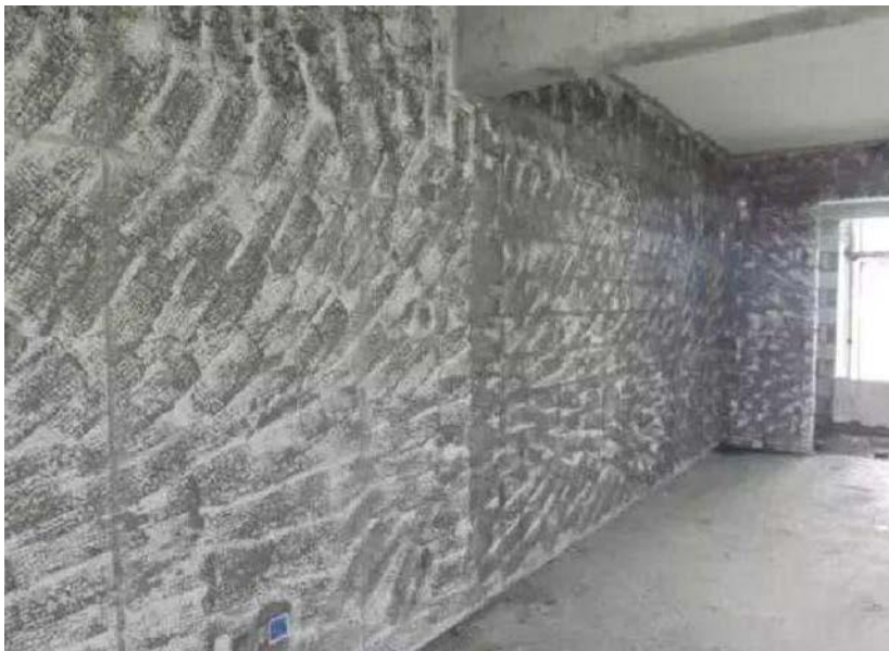
图 4.1.2-1 墙体基层甩浆
