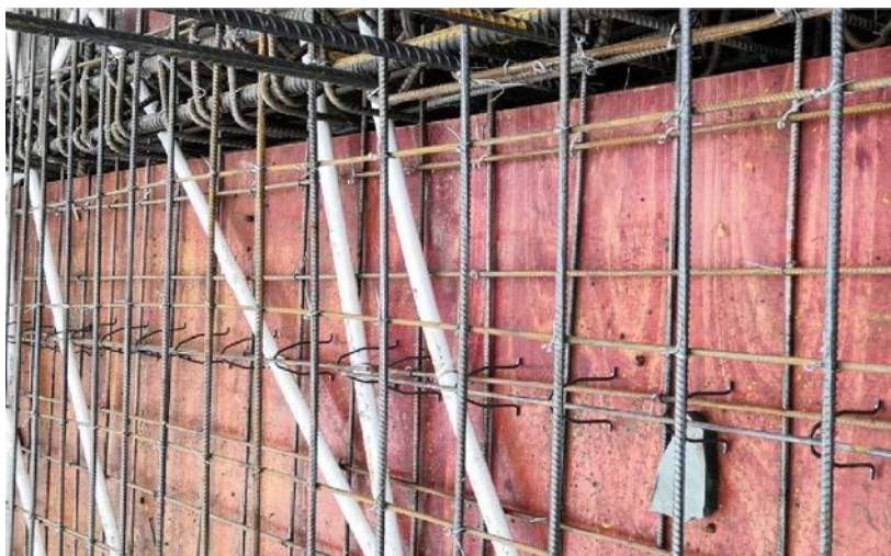
图 2.1.2-5 现浇板铁马凳设置
