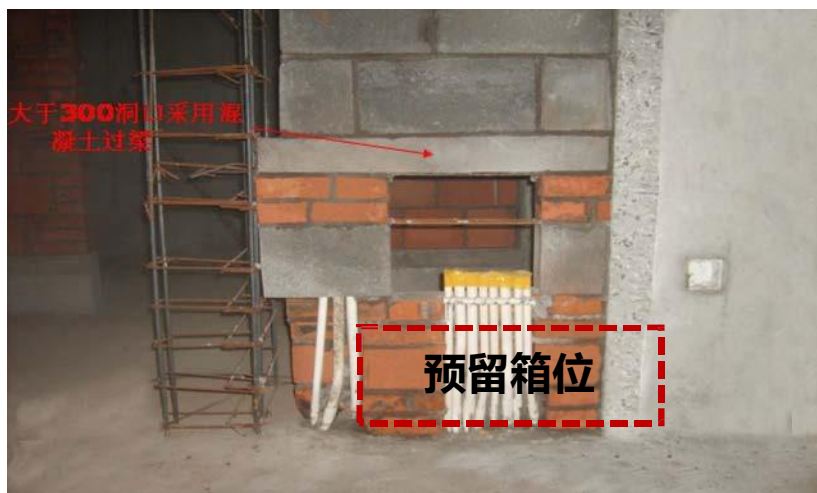
图 4.2.2-5 采用预制混凝土预留箱位图
