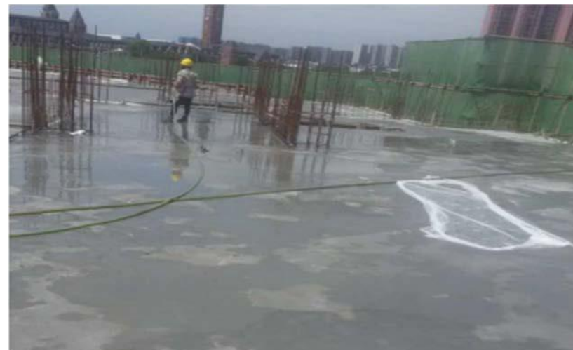
图 2.1.2-10 现浇板面洒水养护
