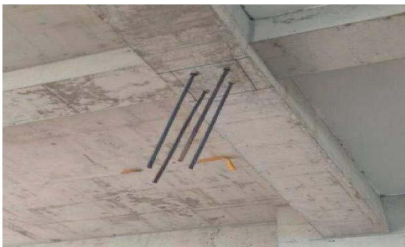
图 4.3.2-1 梁底构造柱钢筋
