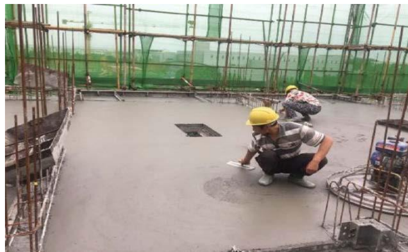
图 2.1.2-8 现浇板人工二次收面
