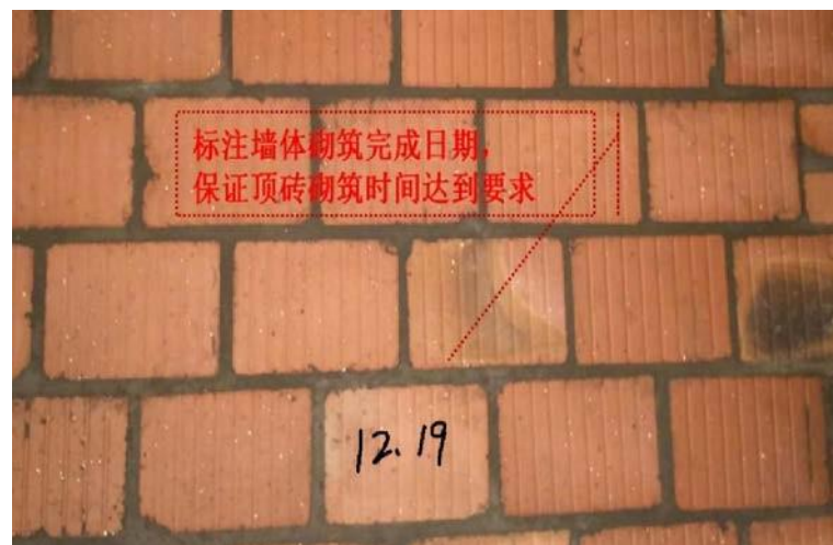
4.3.2-6 砌筑完成后在墙上标明时间
