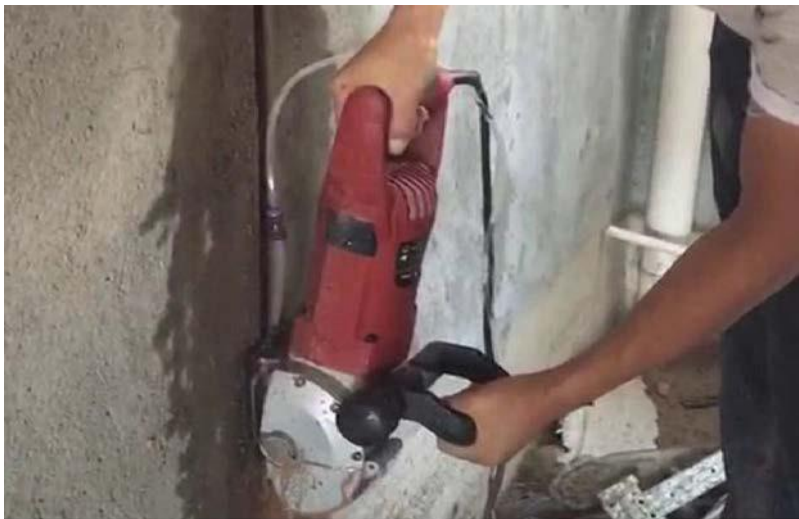
图 4.2.2-3 机械开槽
