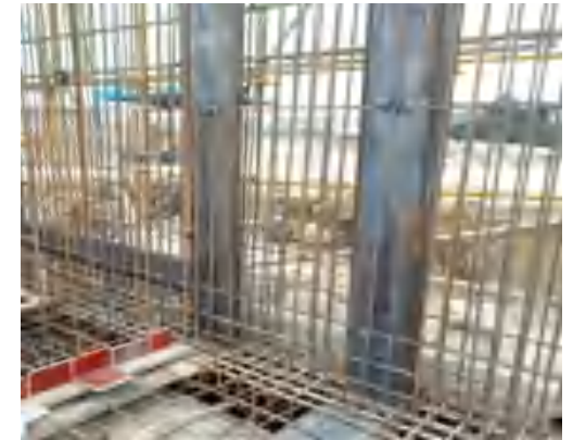
外墙后浇带钢板止水带安装
