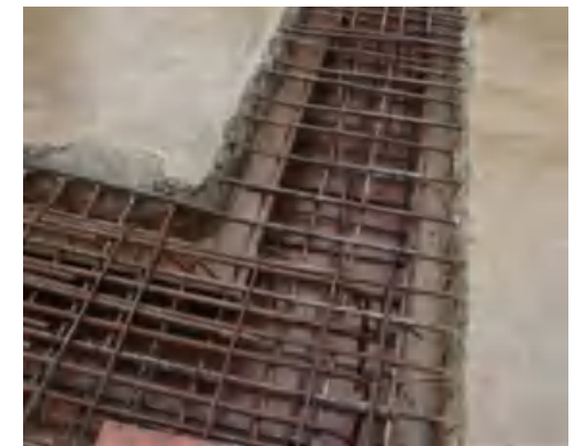
后浇带浇筑封闭前基层清理及凿毛
